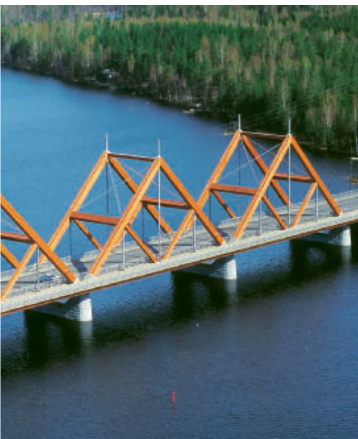
Vihantasalmen puusilta (valmistui 1999) on tiettävästi maailman suurin valtatiellä oleva puusilta. Pituus 182 m ja etäisyys vedenpinnasta korkeimpaan kohtaan on 31 m.
