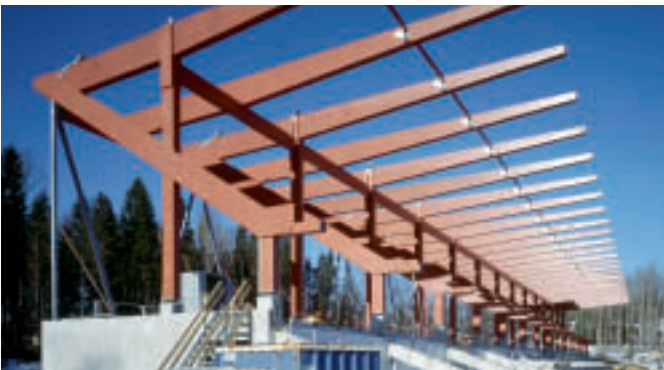
ISS-Stadion Vantaa. Kerto- ja liimapuurakenteita.
