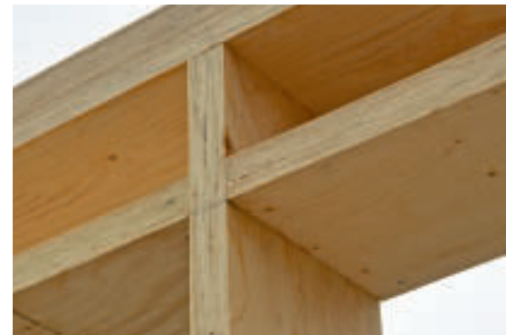
Omakotitalon laajennus Kerto-rungolla.
