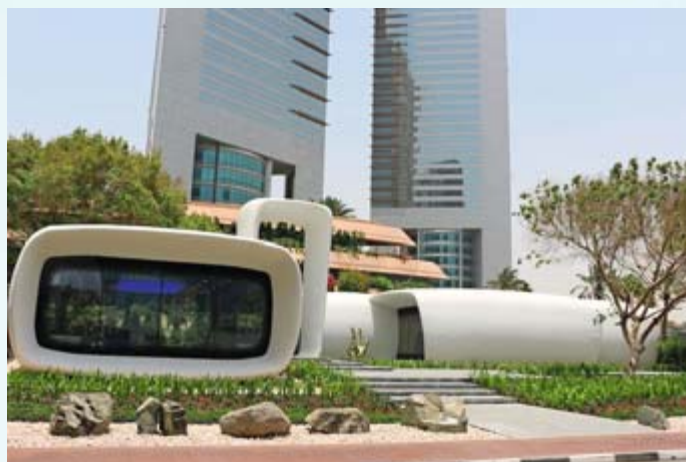
Dubaissa sijaitseva maailman ensimmäinen 3D-tulostettu toimistotalo on kurkistus tulevaisuuteen.
