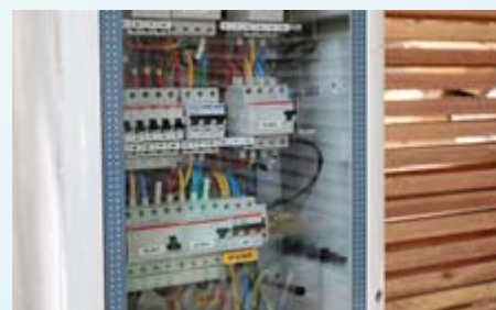
Toimiston taloautomaatio on toteutettu KNX-tekniikalla.
